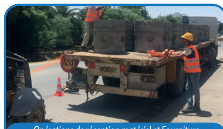
Opérations de réception matériel et Fourniture (PEHD, chambres, Câbles FO et accessoires...) avant pose.
